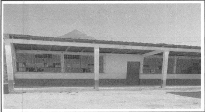
Foto 3: Sustitución de vidrios
