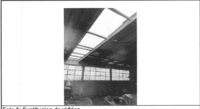
Foto 5: Sustitucion de vidrios
